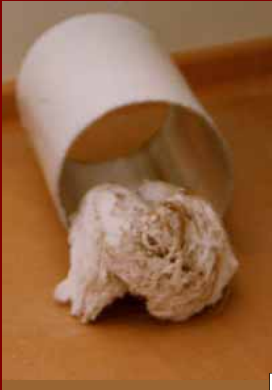
Foto 27: Restos de escayola en el interior del conducto de evacuación de humos, debidos a la descoordinación de gremios
