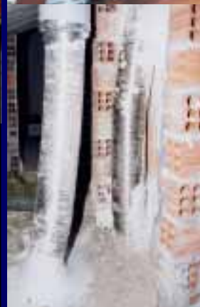
Fotos 49 y 50: Edificio de las Fotos 42 y 47, ha sido preciso realizar DOS conductos independientes para las dos últimas plantas, el material empleado para esta reforma ha sido inoxidable flexible en el paso por la planta bajo cubierta y chimenea modular de doble pared de acero inoxidable para el tramo exterior.
