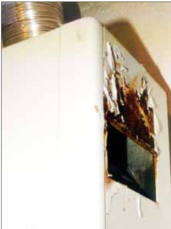
Foto 3A: Efecto del revoco de humos en el cortatiros de la caldera.
