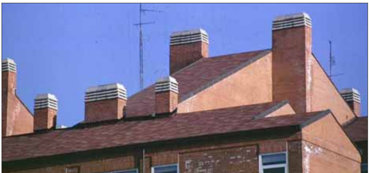
Foto 7: Remates en cubierta de chimeneas y ventilaciones, con elevación correcta.
