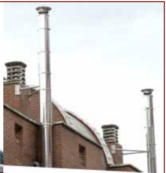
Foto 73: Evacuación por cubierta con chimeneas modulares metálicas, en edificio existente; la solución ha debido ser adoptada ante el incorrecto funcionamiento de las chimeneas de obra; en el detalle se tienen los remates de obra de las chimeneas y los correspondientes a las colectivas metálicas.
