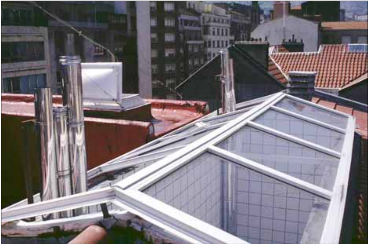
Foto 67A: Remate en cubierta de las chimenea de la foto 67B.
