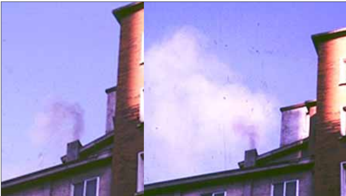
Foto 2: Efecto del viento en los remates de cubierta de las chimeneas.
