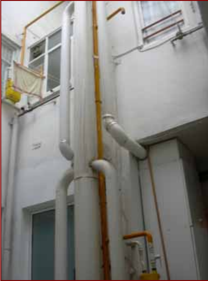
Foto 72: Solución en edificación existente para calderas atmosféricas, mediante chimenea colectiva metálica sin aislamiento por patio interior, con conductos individuales con altura equivalente a una planta.
