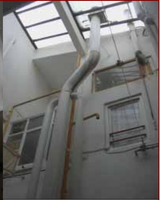
Foto 72: Solución en edificación existente para calderas atmosféricas, mediante chimenea colectiva metálica sin aislamiento por patio interior, con conductos individuales con altura equivalente a una planta.
