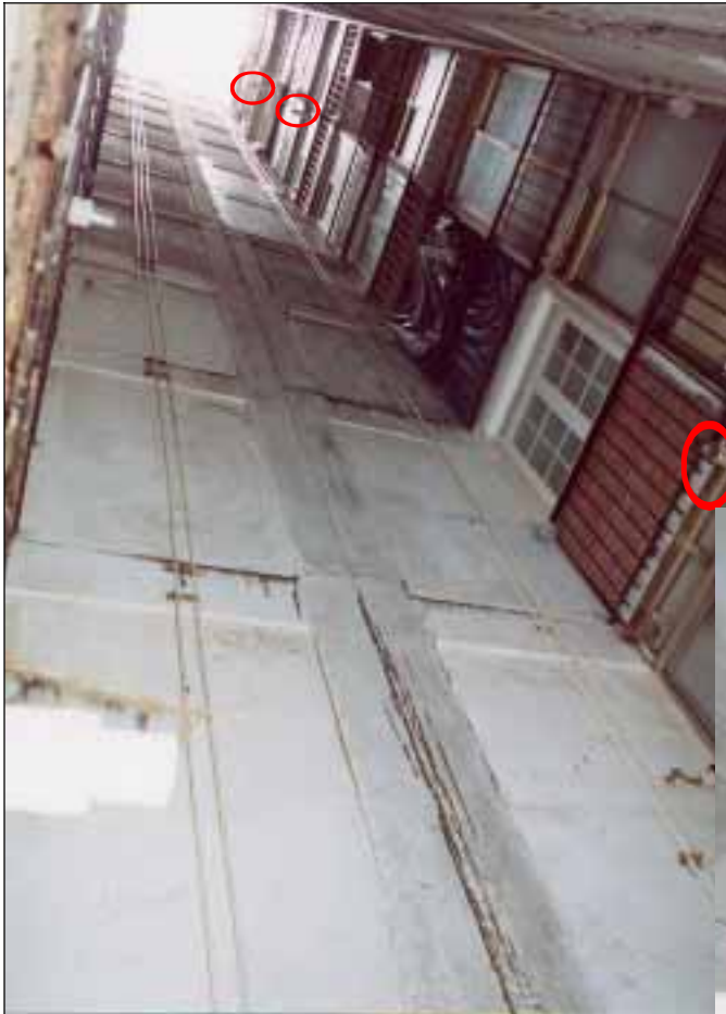
Foto 68B: Patio interior Correspondiente al edificio de la Foto 68A; en el cual se ha instalado una chimenea rectangular de aluminio rígido, con dos emboques por planta, sin aislamiento térmico.
