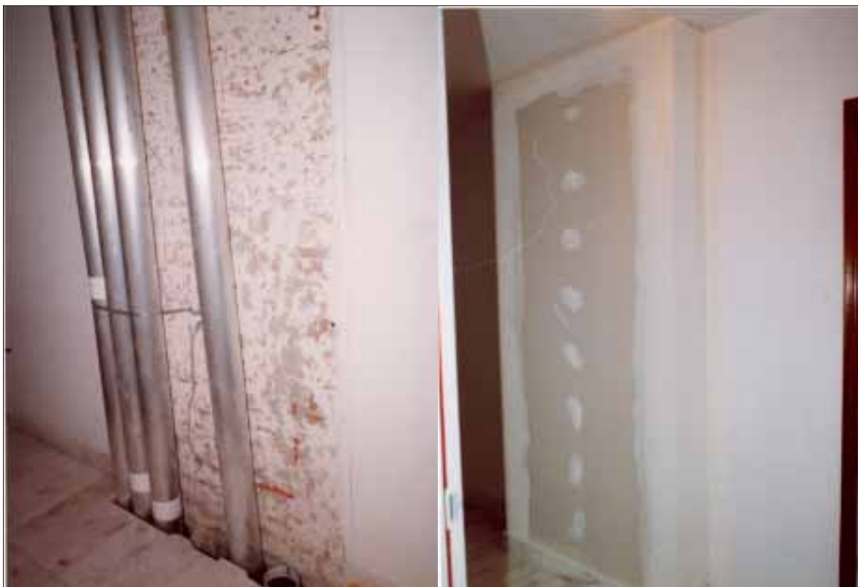
Foto 34: Instalación de chimeneas individuales, con conducto de aluminio, discurriendo por la caja de escaleras; el conjunto se ha rematado con panel que incorpora el aislamiento térmico.
