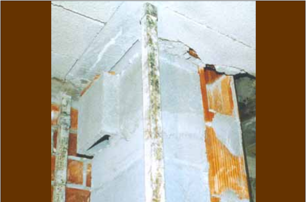
Foto 13: Emboque a Chimenea Colectiva de Hormigón (NTE-ISH/74). Embocadura mediante Pieza Especial ISH-9; el conducto posterior es de ventilación según ISV
