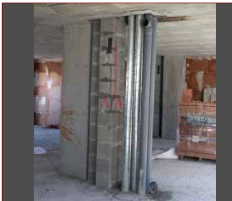
Foto 46: Chimenea colectiva de hormigón; se han marcado con una flecha, en la dirección del flujo, las piezas de conexión del conducto auxiliar al común; de este modo se evitan errores en el montaje y se facilita el control de obra. La pieza de conexión se ha situado demasiado baja, lo que reduce el conducto auxiliar a menos de una planta; debiera haberse situado dos piezas por encima.
