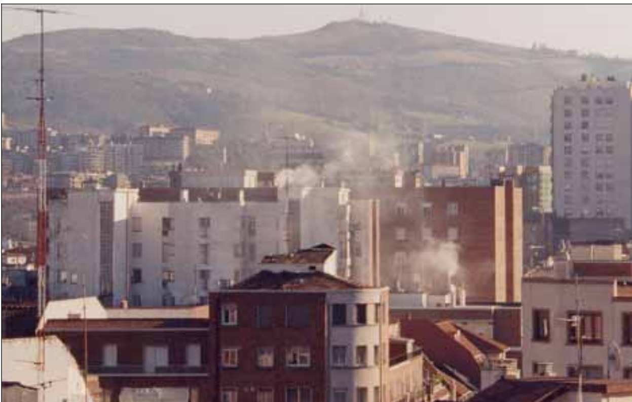
Foto 8: Efecto del viento en los remates de las chimeneas; las chimeneas no han respetado las alturas indicadas en la normativa; se observa como el viento provoca un movimiento de los humos hacia las viviendas colindantes; en primer plano se comprueba como, por el contrario, las antenas de TV han sido elevadas hasta un punto que permite la correcta visión.
