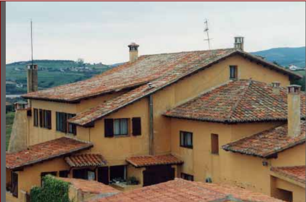
Foto 22: Edificio con varias chimeneas, es de destacar que todas las correspondientes al edificio original fueron correctamente elevadas sobre la cumbre, mientras que la chimenea modular de la instalación de calefacción apenas supera el paso de cubierta.
