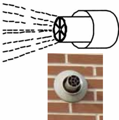
Figura 9C: Descarga libre de caldera estanca, el penacho se corresponde con el mostrado en la figura 9A .
