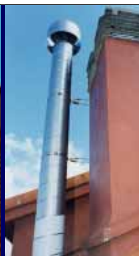
Fotos 49 y 50: Edificio de las Fotos 42 y 47, ha sido preciso realizar DOS conductos independientes para las dos últimas plantas, el material empleado para esta reforma ha sido inoxidable flexible en el paso por la planta bajo cubierta y chimenea modular de doble pared de acero inoxidable para el tramo exterior.
