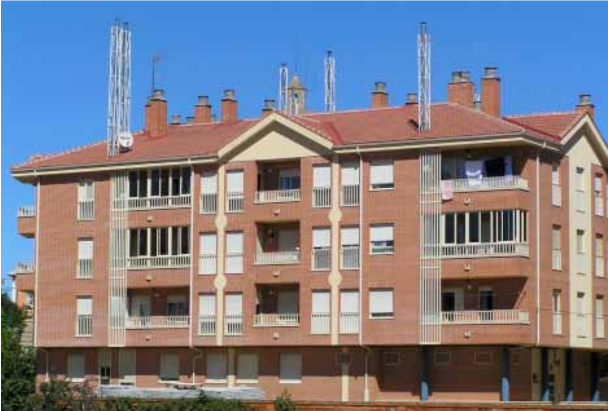
Foto 56A: Chimeneas elevadas por encima de los obstáculos colindantes, se ha dispuesto una estructura para garantizar su estabilidad.
