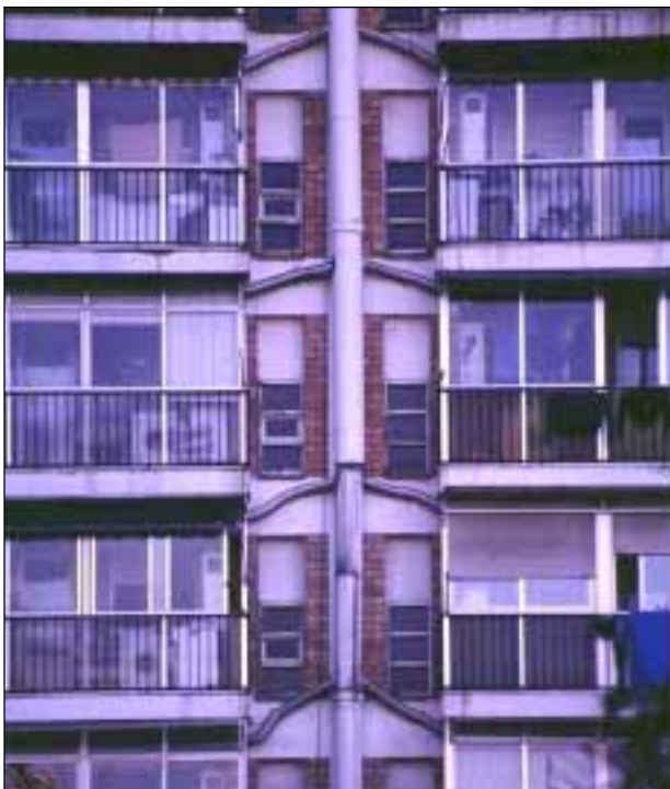
Foto 65B: Evacuación por cubierta, detalle del edificio de la Foto 651A. La instalación es anterior a la aprobación del RIGLO y, por supuesto de las normas UNE 123.001 y 60.670/99.
