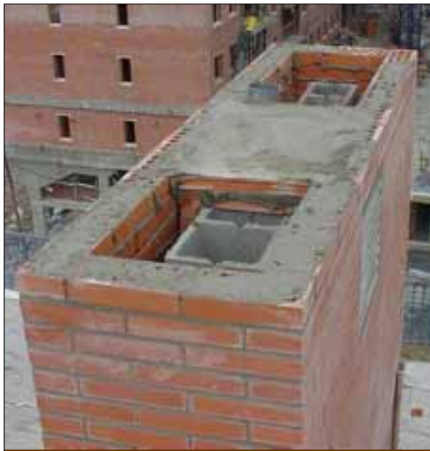
Foto 51C: Remate de cubierta del conjunto de ventilación: Chimenea Colectiva, Ventilación Superior Colectiva, Extractoras individuales. Separación entre las extractoras y resto de servicios, con rejilla lateral para las mismas. Tapa en remate final para evitar interferencias entre extractoras y tiro natural.
