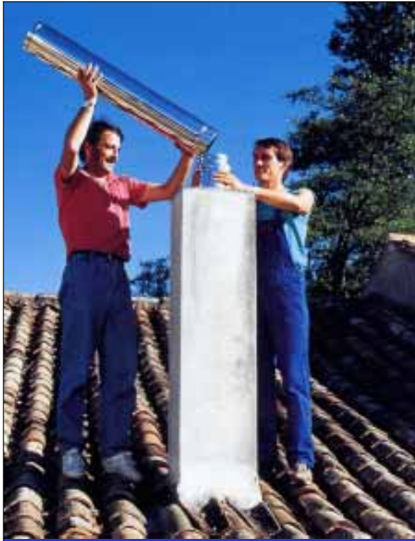
Foto 69A: Entubado interior de chimenea existente, con inoxidable de simple pared rígido. Fabricante PUJOLAT .
