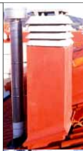
Fotos 49 y 50: Edificio de las Fotos 42 y 47, ha sido preciso realizar DOS conductos independientes para las dos últimas plantas, el material empleado para esta reforma ha sido inoxidable flexible en el paso por la planta bajo cubierta y chimenea modular de doble pared de acero inoxidable para el tramo exterior.
