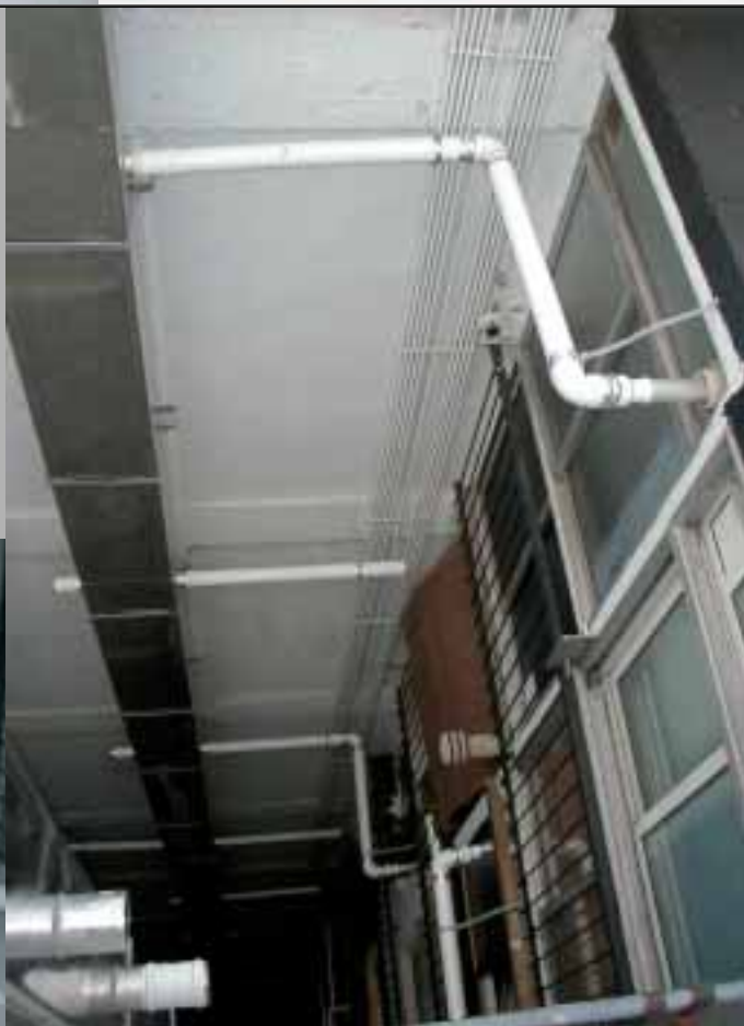
Foto 68B: Patio interior Correspondiente al edificio de la Foto 68A; en el cual se ha instalado una chimenea rectangular de aluminio rígido, con dos emboques por planta, sin aislamiento térmico.
