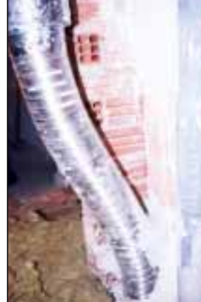
Fotos 49 y 50: Edificio de las Fotos 42 y 47, ha sido preciso realizar DOS conductos independientes para las dos últimas plantas, el material empleado para esta reforma ha sido inoxidable flexible en el paso por la planta bajo cubierta y chimenea modular de doble pared de acero inoxidable para el tramo exterior.
