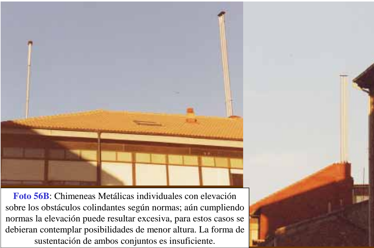
Foto 56A: Chimeneas elevadas por encima de los obstáculos colindantes, se ha dispuesto una estructura para garantizar su estabilidad.
